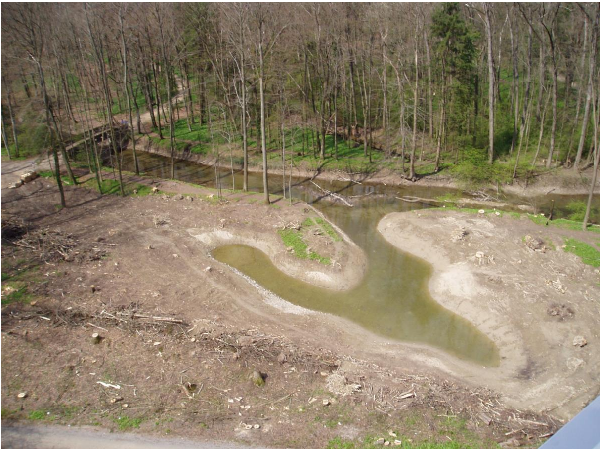
Bild 1 Nach Abschluss der Wiederherstellung der Flutmulde 2004. ( https://bachverein.ch/d/projekte/aufwertung-frey-kanal/ )
