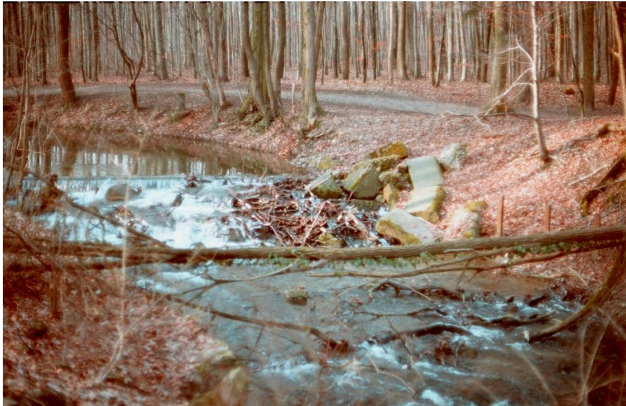
Bild Rüscherli vor der Sanierung
